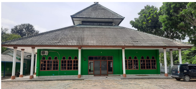
Gambar 9. Masjid Agung Al-Ikhlas Lampung Tengah
